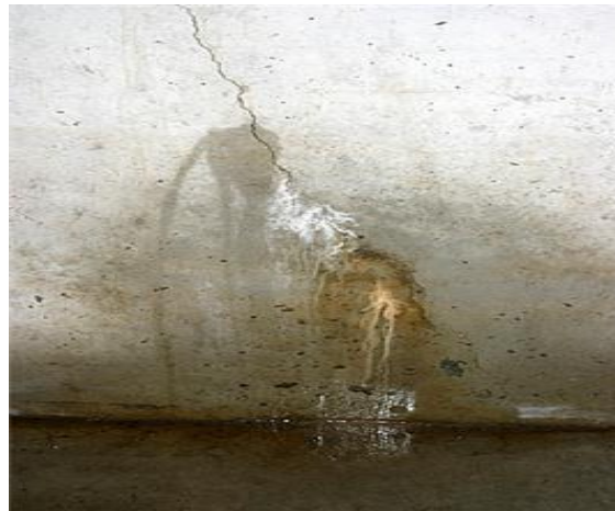
Fig. 2 Heaving due to thaumasite/ettringite attack
