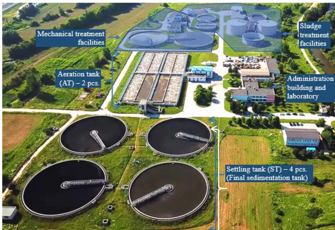
Fig. 3 View of WWTP Butila ( https://youtu.be/w8nA-Fb:0nU , accessed 21.06.2019)
