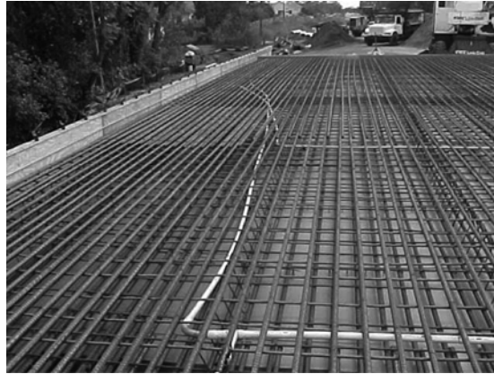
Fig. 5 PVC conduit protection
