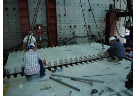
(d) PC deck installation
