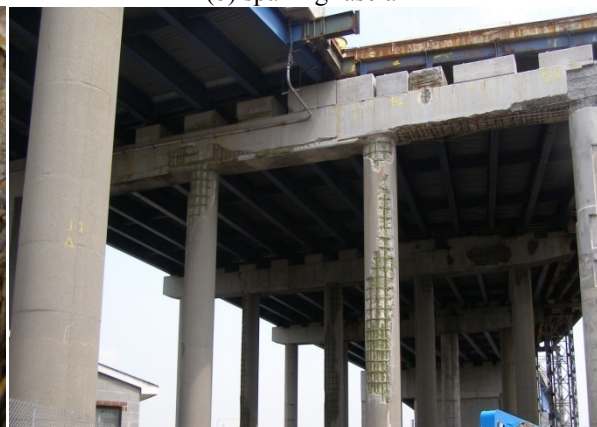
(d) pier rehabilitation at expansion joint
