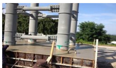
(d) Pouring footing concrete
