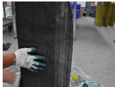
(d) Longitudinal reinforcement
