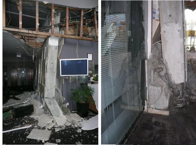
Fig. 4 Failure of wall D5-6 (Kam et al. 2011)
